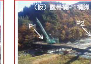
(仮)腹帯橋P1橋脚では、フーチング部の施工が完了し、柱部の施工を行っています。
