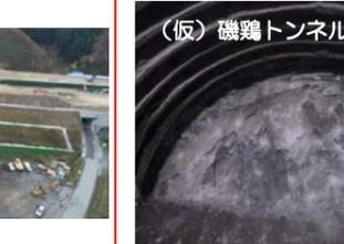
(仮)磯鶏トンネル(小山田側)の掘削を行っています。全長1,554m(709mを飛鳥建設で施工)のうち359mまで進んでいます。
