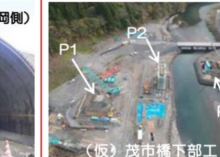
(仮)茂市橋P3橋脚では、埋戻しを行っており、P2橋脚ではコンクリート打設を、P1橋脚では締切鋼矢板の打設を行っています。
