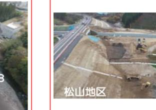
松山地区では、「宮古道路」の仮設道路撤去が完了し、法面の排水工を施工しています。
