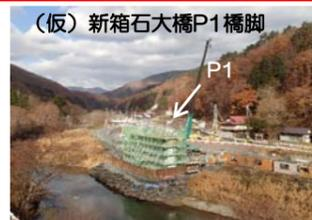
(仮)新箱石大橋P1橋脚の柱部の施工を行っています。
