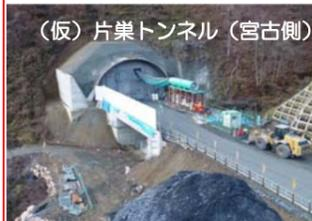
(仮)片巣トンネルの掘削を行っています。全長559mのうち79mまで進んでいます。
