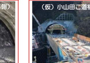
(仮)小山田こ道橋上部工では、床版工の鉄筋組立を行っています。
